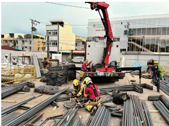
圖 9、建築工地現場鋼筋鐵材堆放
