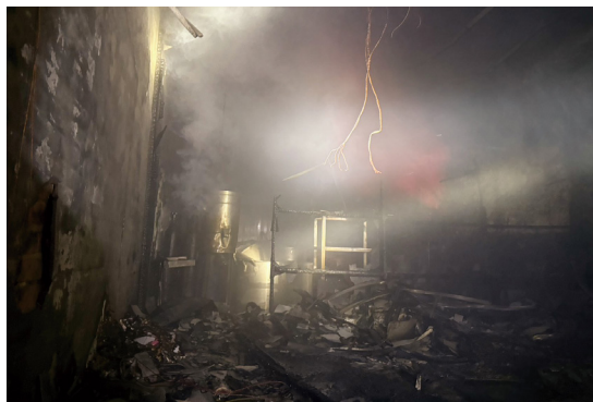
圖 1、淡水區忠○街民宅火警現場涉嫌毒品製作氣體瀰漫情形
