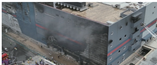
圖 5：UAV 熱顯監控熱源位置
