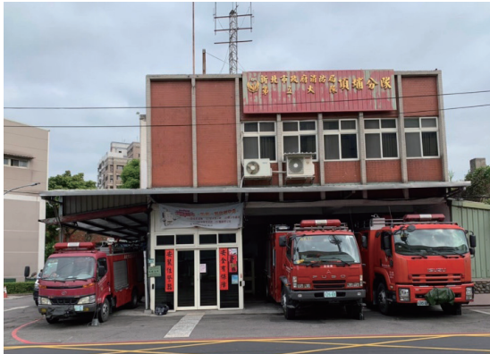
圖 2、新北市政府消防局頂埔分隊舊廳舍拆除前正面照
