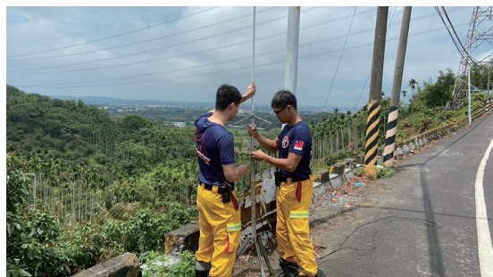
圖 10、資通訊設備系統實地架設作業 (2)
