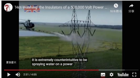
圖 13、細水霧應用於 50 萬伏輸電線路清洗
