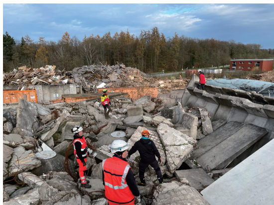
圖 9、Mosbach TCRH 訓練中心瓦礫訓練場，此為結構較複雜瓦礫場，除了瓦礫搜索外，常提供給重型救援訓練時，救災團體與 BRH 互相搭配訓練使用
