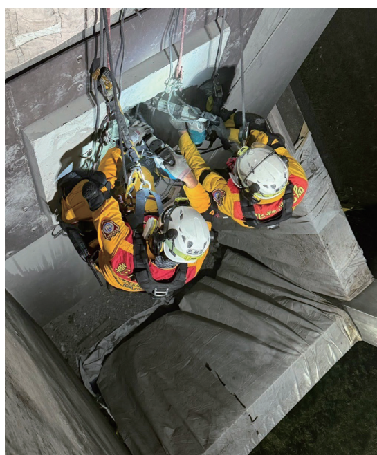
■ 圖 4、利用繩索技術進行水泥牆面破壞
