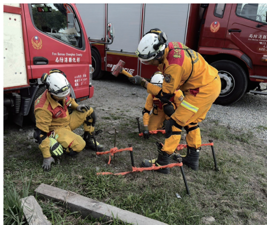
■ 圖 3、利用打樁方式架設固定點
