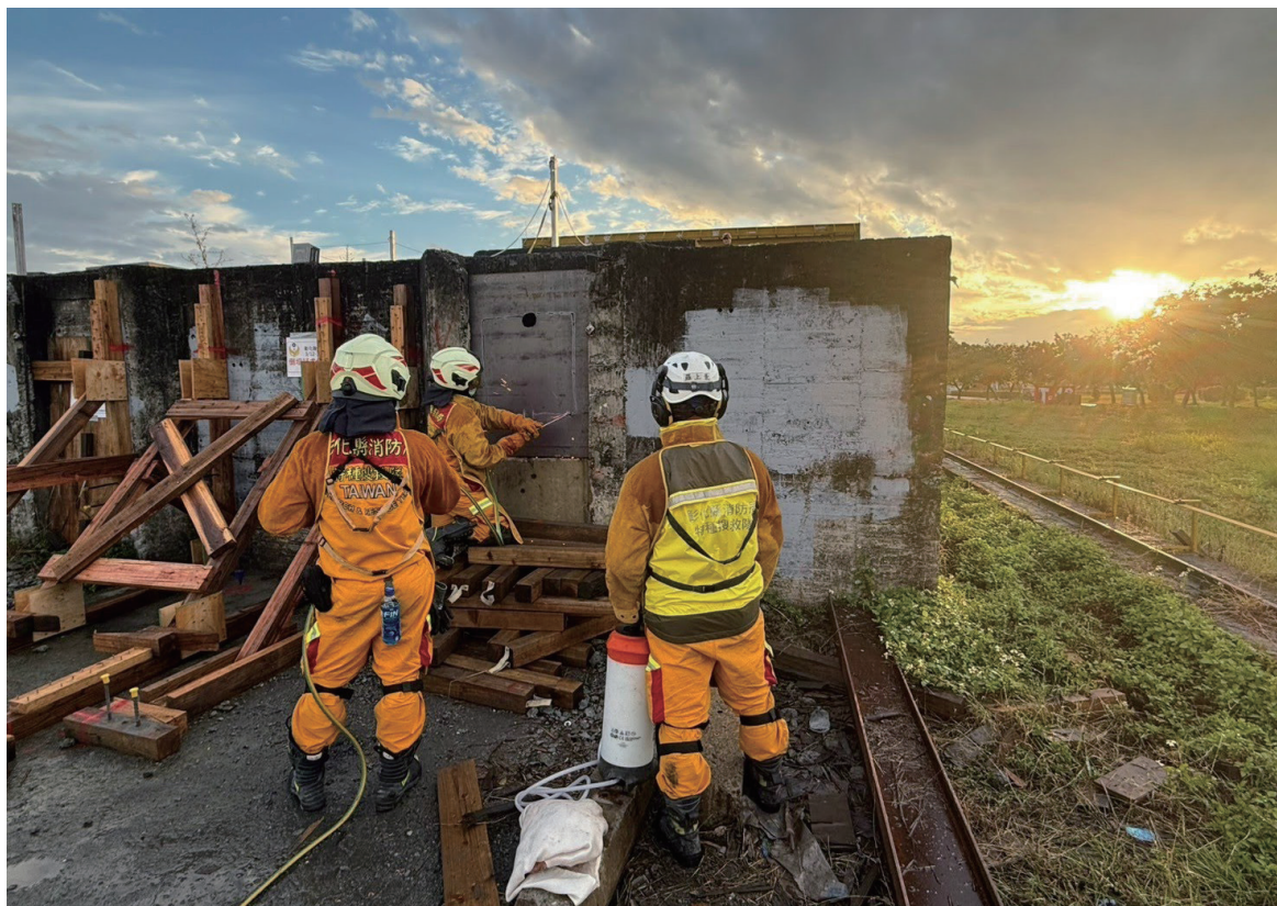
圖 5、雨過天晴的支撐與破壞作業
