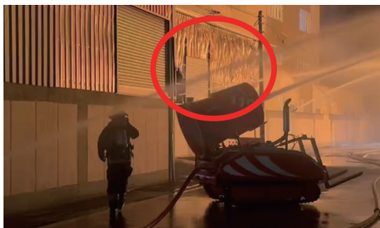
■ 圖 3、以 113 年 5 月火警為例，火場第二面的建築物已受到輻射熱的影響（紅圈處）
