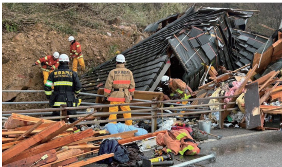
圖 4、道路受損復原工作
