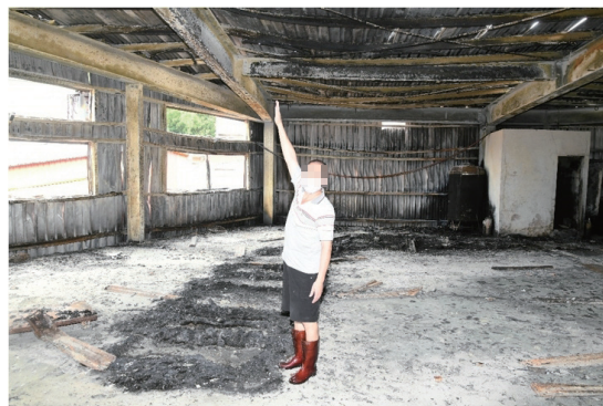
圖 5、勘察現場據員工供述指認，可知泡棉裁切廠2樓泡棉半成品儲藏區之泡棉半成品高度約2公尺左右
