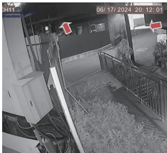
圖 7、該址西北側工地圍牆設有監視錄影畫面，記錄於113年06月○日20時12分01秒始數名員工前往1樓西側察看（右箭頭），且2樓北側中間鐵皮有透出火光情形（左箭頭），其上方屋簷持續竄出火勢並向西側擴大延燒
