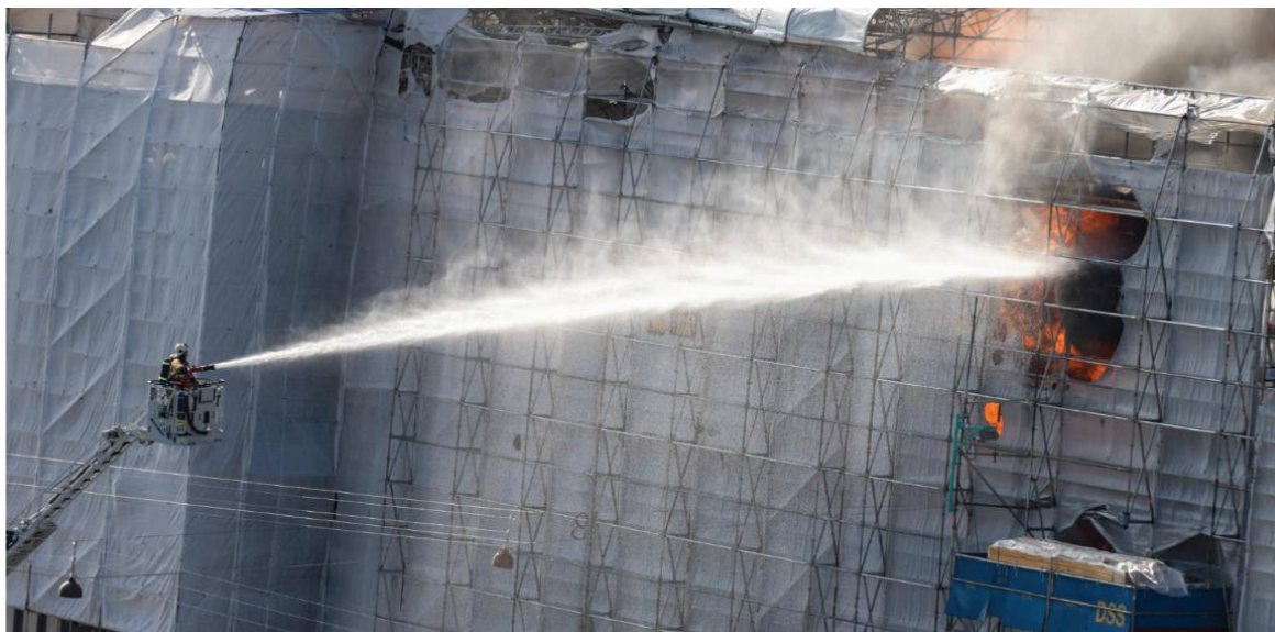
圖 4、防塵網阻隔滅火
