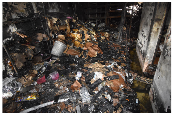
圖 13、以堆放廢電池處受燒燬最嚴重
