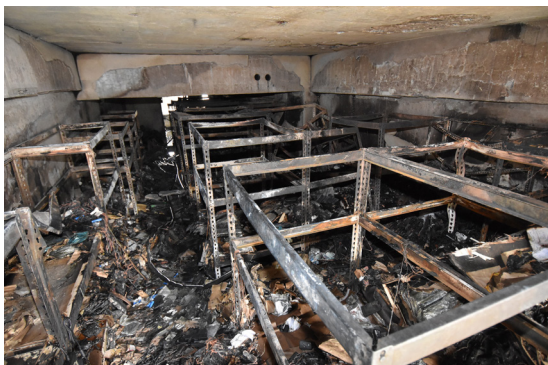
圖 12、起火戶全區堆放各式筆記型電腦電池及筆記型電腦用品
