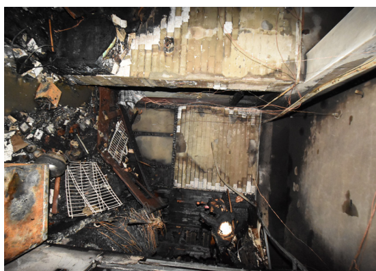
圖 16、玄關及擺放物品均以靠鋰電池組擺放處受燒燬較嚴重
