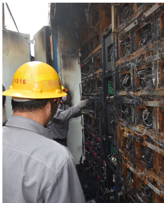
圖 8、檢修人員現場協助拆解情形
