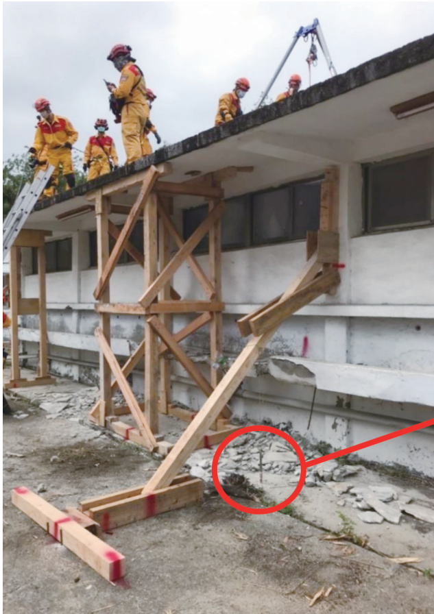
■ 圖 18～19、支撐架構監測與標記方式（2022 年 921 國家防災日演習由筆者單位在花蓮縣消防局訓練基地進行的木架支撐作業現場照片）
