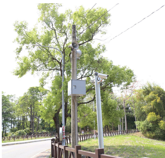
■ 圖 5. 近水域輔助偵測系統現場揚聲器與鏡頭等設備（照片來源：嘉義市政府）
