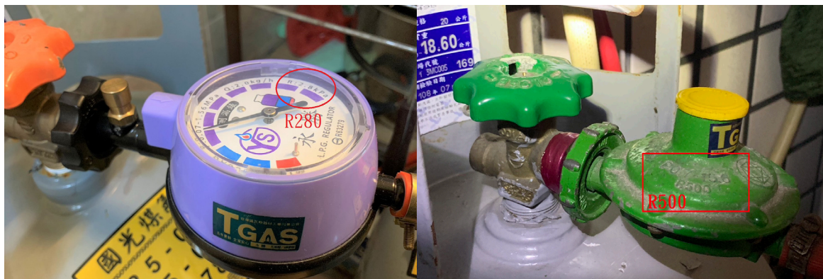
圖 4、（左）家用瓦斯爐正確使用 R280 壓力調整器（右）家用瓦斯爐錯誤搭配 R500 壓力調整器（作者拍攝繪製）
