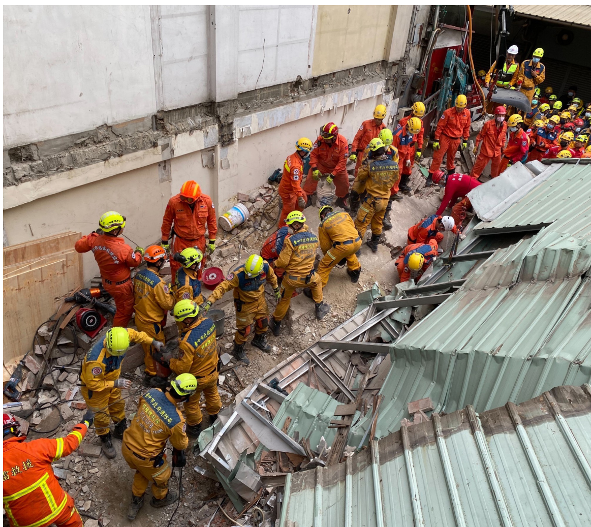
■ 圖3、人員進行清理作業，將內部廢料移出方便搜索
