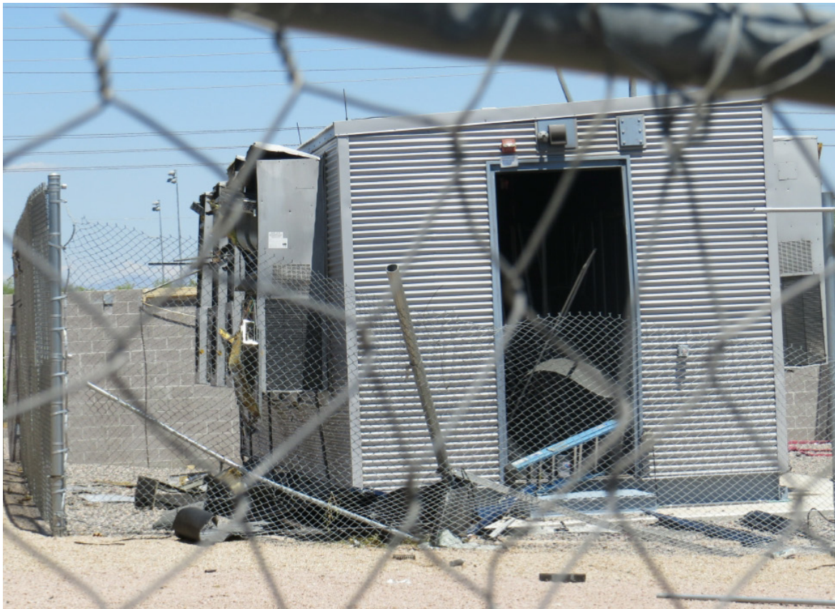
■ 圖 10、事故儲能系統圖（圖片來源：APS）
