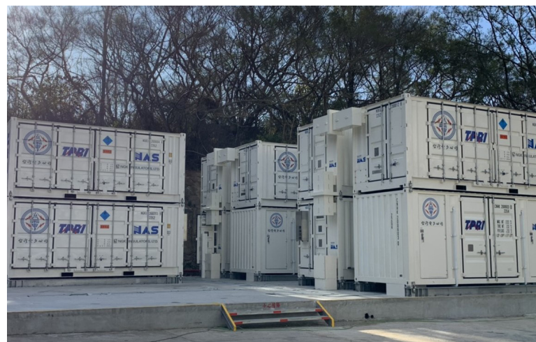
■ 圖 6、金門夏興電廠鈉硫電池儲能系統。（圖片來源：公益國際）
