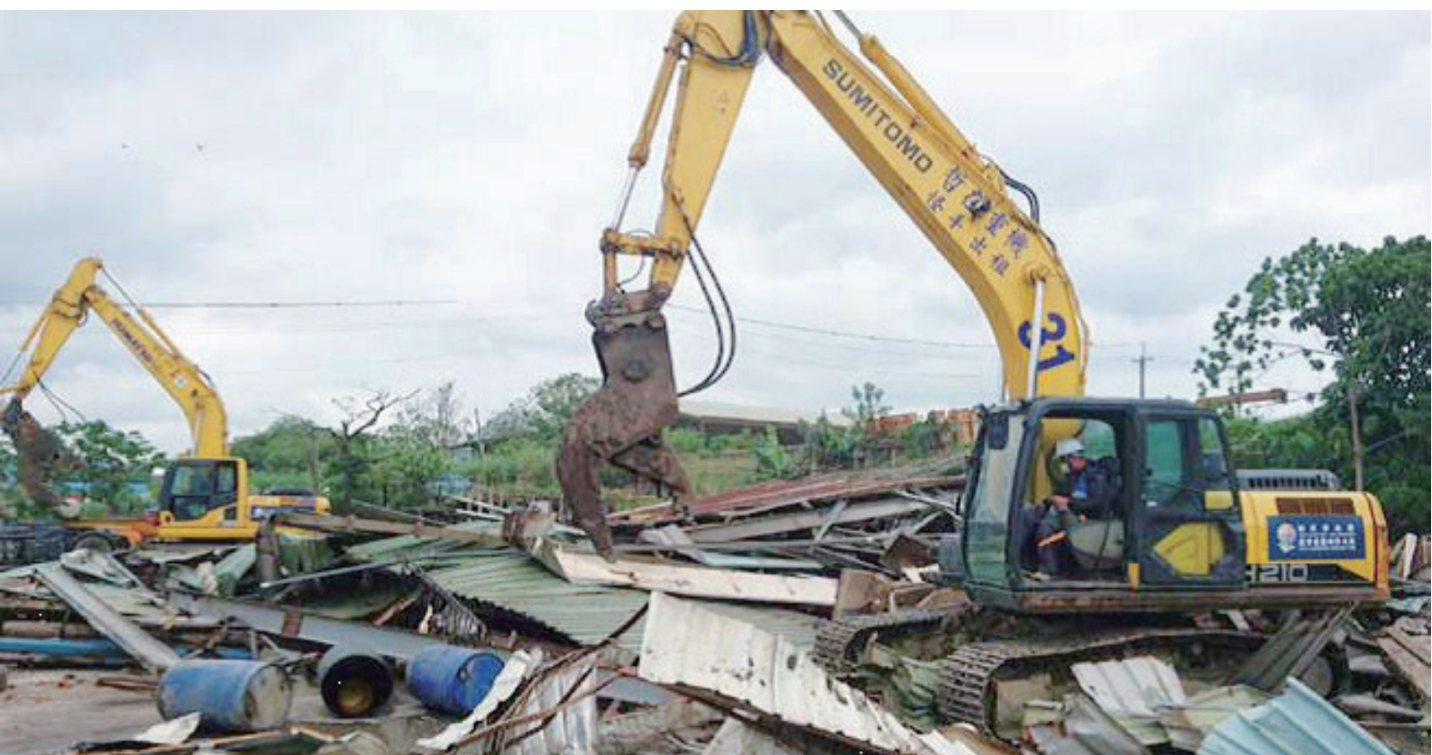
圖 3、違章建築拆除大隊出動怪手，拆除五股區非法佔地業者建物
