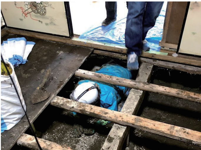
圖 14、志工協助屋下污泥清除
