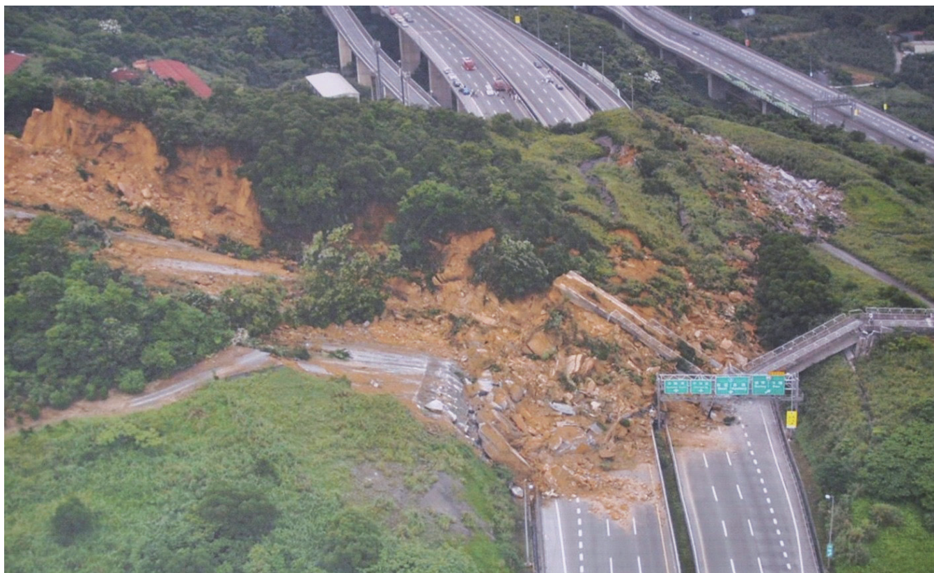
圖 6、2010 年國道三號山崩現場空照圖 (高公局資料)
